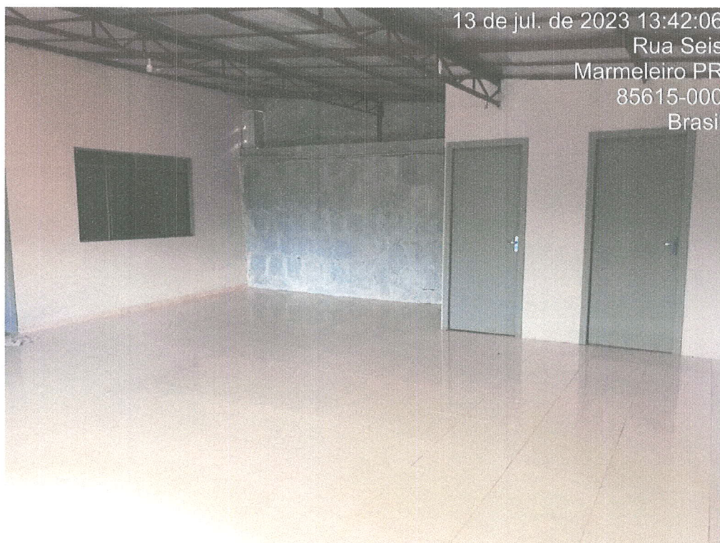
Figura 04: Vista interna parte do subsolo.
